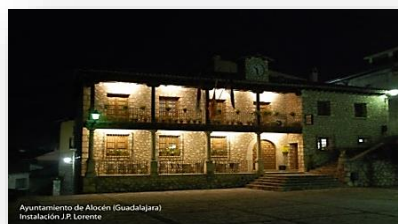
Asuntamiento de Alcobén (Guadalajara) Instalación J.P. Lorente
